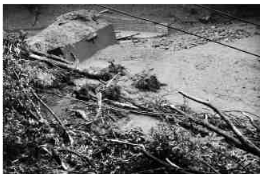
土石流で決壊した砂防ダム(写真:同上)
