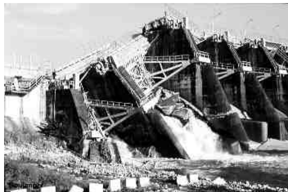
石岡ダム決壊(1999年9月21日台湾集集地震 マグニチュード7.6)
