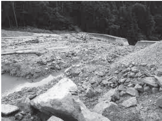
奥山に建設した「山の神砂防ダム」は土砂が堆積して危険。さらに上の新たなダム工事に着工している。 2023年10月3日
