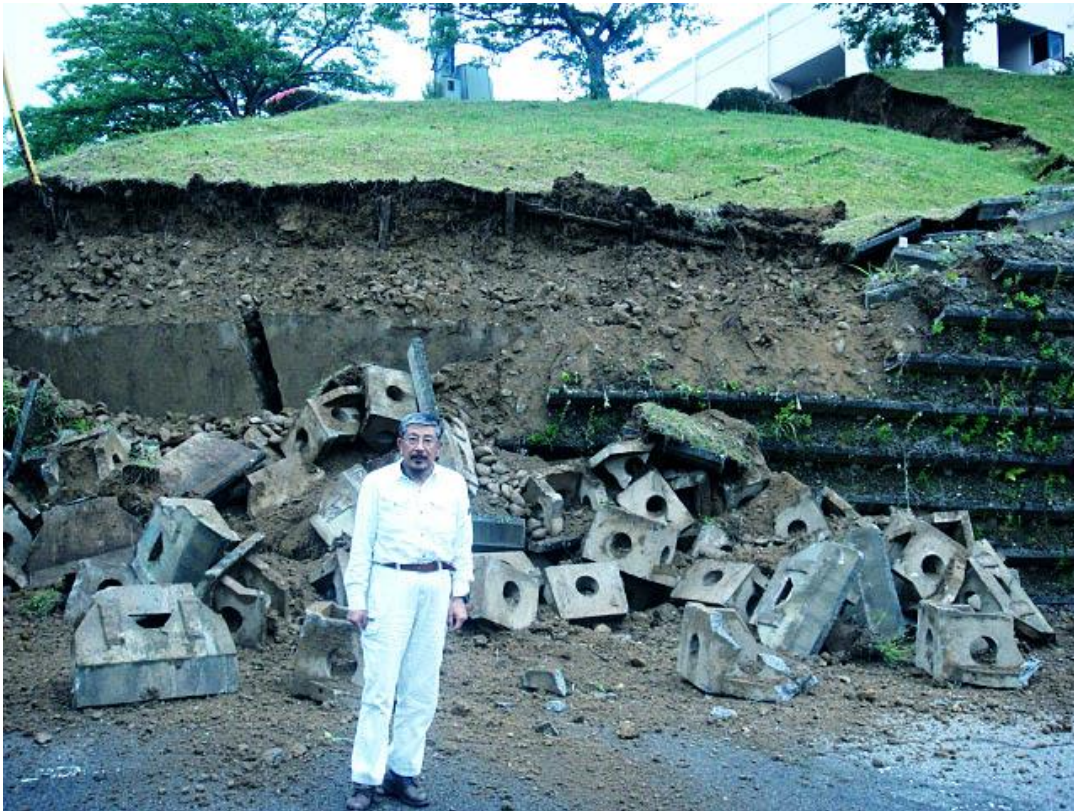
村上市山北総合体育館 入口付近 2019年6月19日午前4時
