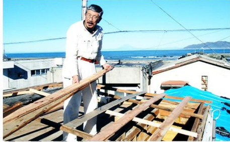
館山市布良地区の被災家屋で屋根修復の応急処置に取り組み岩村牧師
